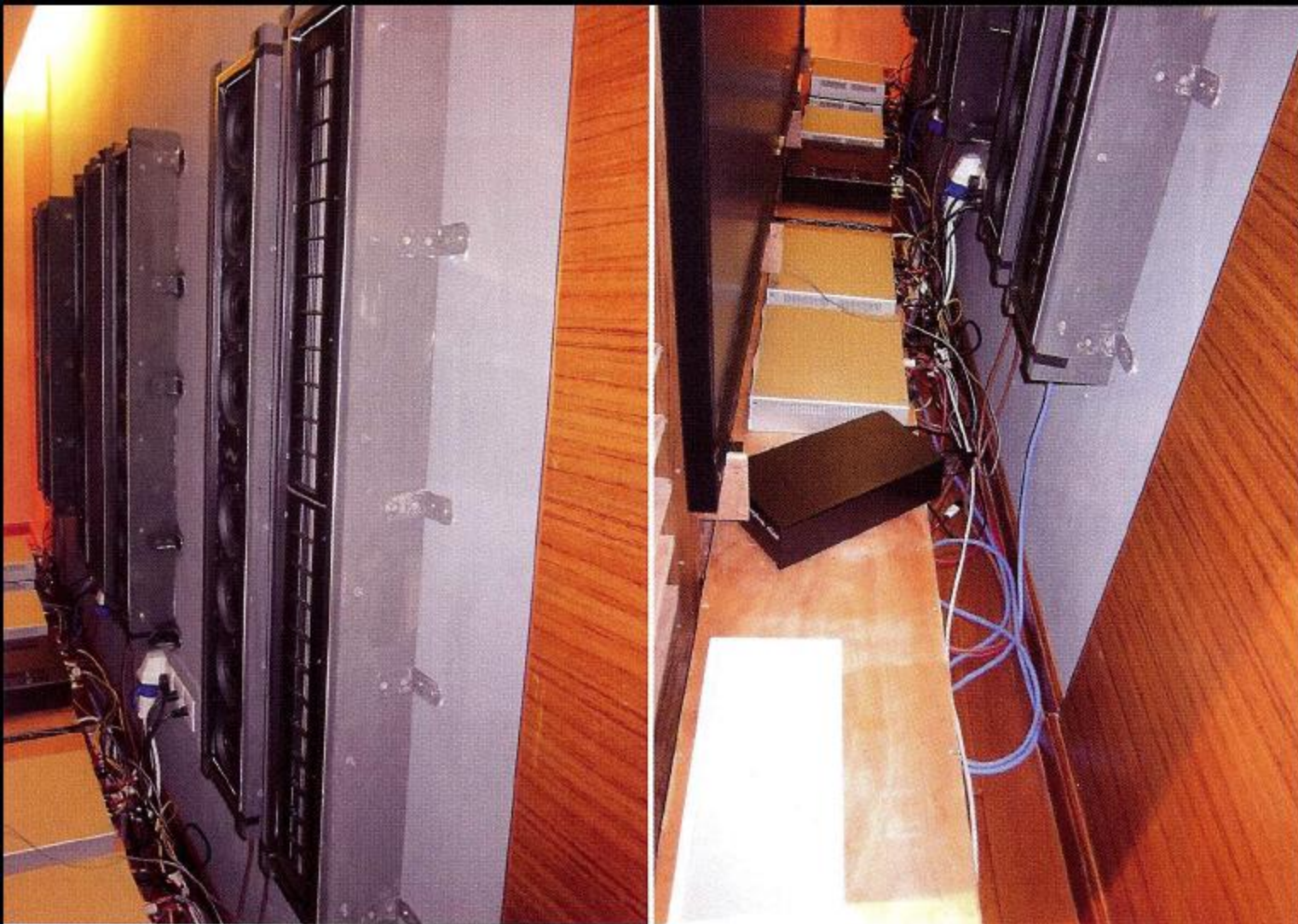
△在透聲幕後可以清楚看見安裝了兩隻掛牆的 L100 作為左、右主聲道，中間是 C150。
